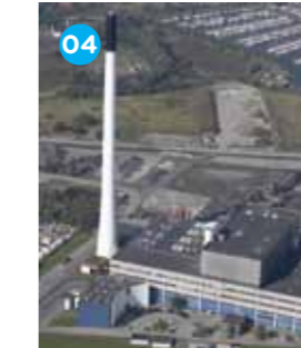
04 AMAGERFORBRÆNDING Waste-to-energy CHP
