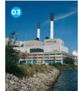
03 VATTENFALL AMAGERVÆRKET Multi-fuel CHP, heat storage
