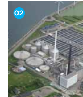
02 LYNETTEFÆLLESSKABET Waste-to-energy (sludge), heat only
