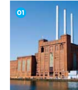
01 DONG ENERGY SVANEMØLLEVÆRKET Gas-fuelled CHP
