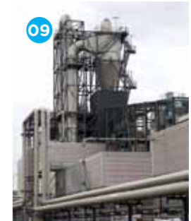
09 VEKS KØGE KRAFTVARMEVÆRK Biomass CHP
